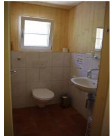
Innenansicht neues Spül-WC
