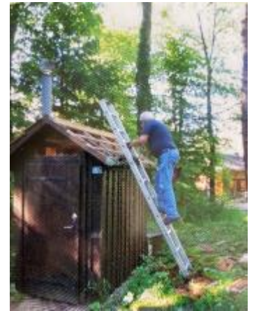
Rückbau altes WC
